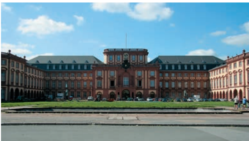
Mittelbau mit den neuen Mansarddächern
