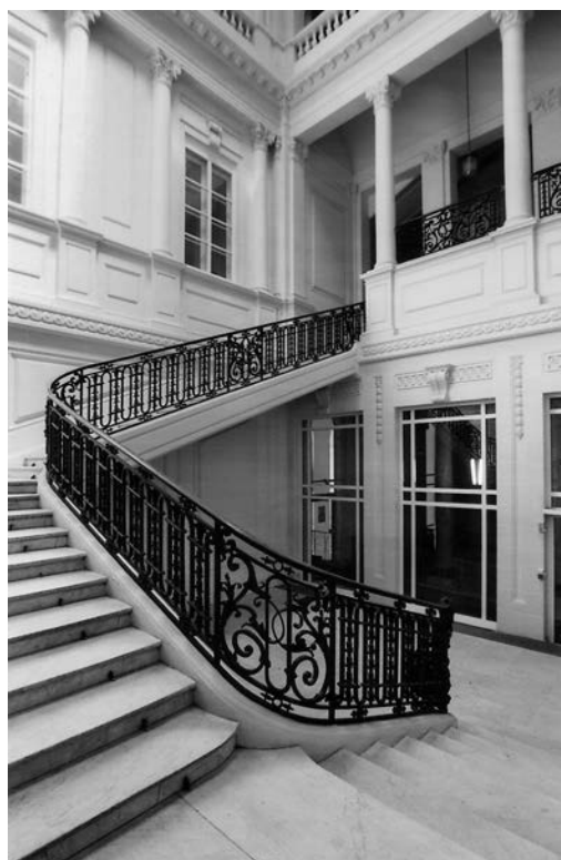
Treppenhaus des Palais Lanz im heutigen Zustand Aufnahme des Verfassers
