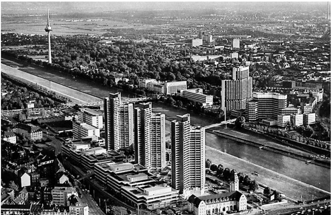
Neckaruferebebauung: Wohnen und Gewerbeschulen auf dem Nordufer, das Collincenter mit Büros und Wohnungen auf dem Südufer 1975-82, Konzept Karl Schmucker
