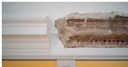
Original Stuckgesims im 1. Wohnzimmer der Beletage
