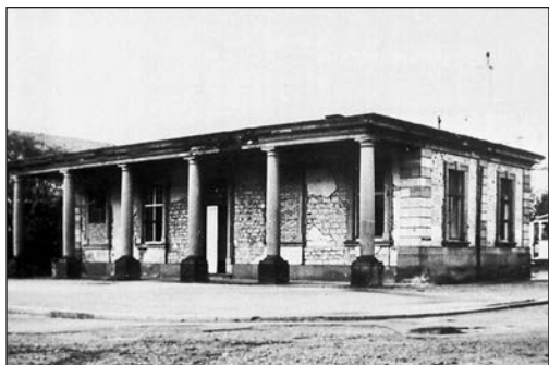
Das westliche teilinstandgesetzte Wachthäuschen, 1950 Oberfinanzdirektion Karlsruhe
