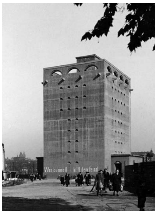
Hochbunker Luisenring für 1000 Personen, 1940 Städtisches Hochbauamt
