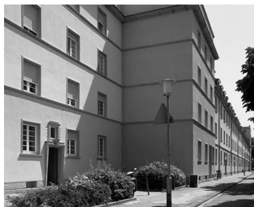
Großsiedlung Erlenhof, Rückansicht Erlenstraße
