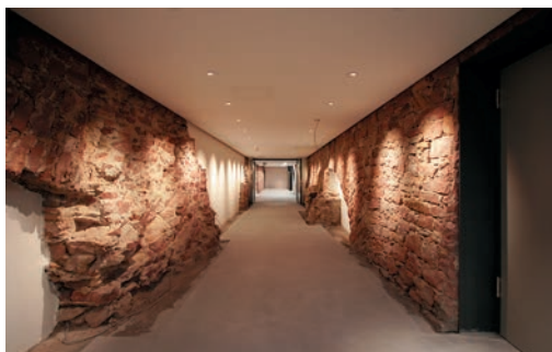
Neuer Durchgang mit Schlossfundamenten unter dem Haupttreppenhaus
