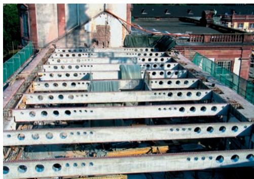
Stahlverbundträger über dem 2. OG als Tragkonstruktion für die Bibliothek
